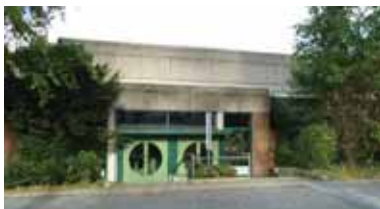
Sporthalle Kuhlo-Realschule · Ehlenruper Weg
